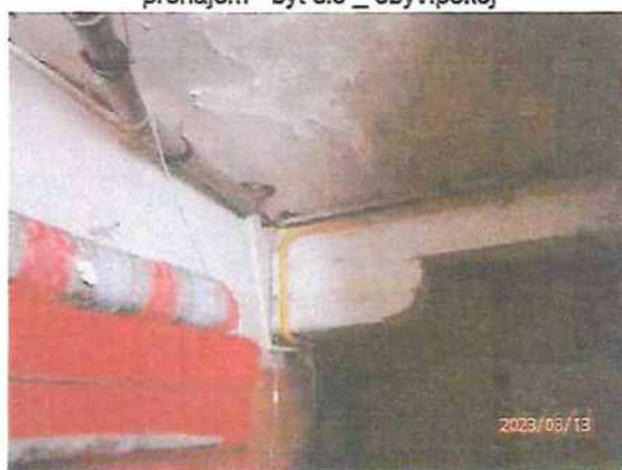
společná chodba u bytu č.5
