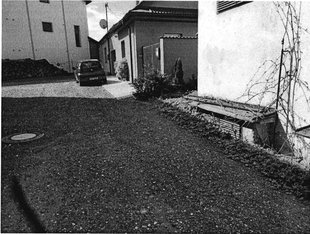
Obrázek č.2 – Nové zpevněné plochy (vjezd a chodník ze zámk.dlažby) – 07/2023
