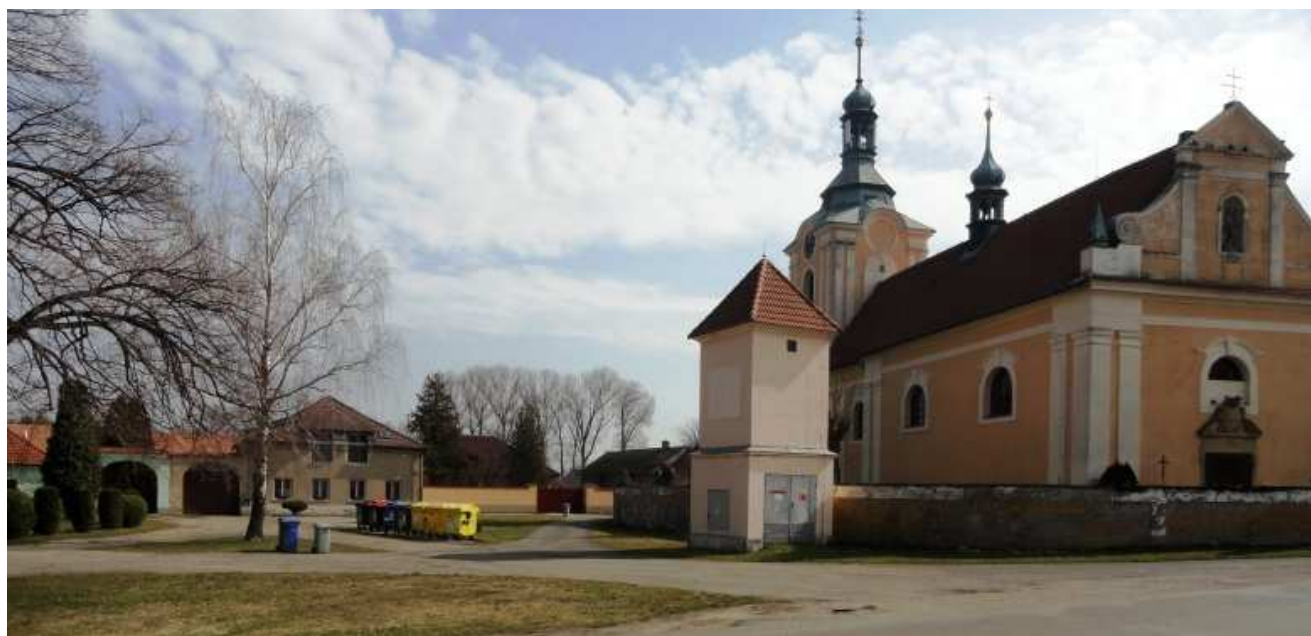
Centrum obce – kostel, trafostanice a sběrné místo tříděných odpadů
