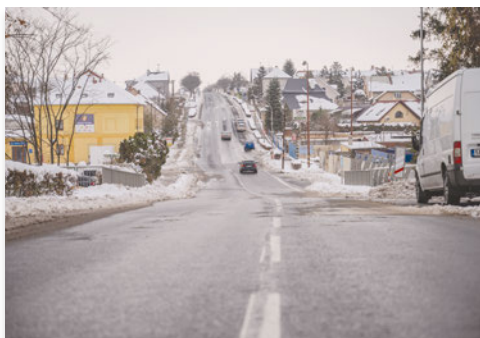
První prosincový den byl otevřen opravený most v Pražské ulici.
