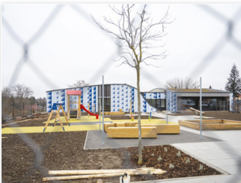
Stavba nové budovy MŠ se blíží do finále. Pokud půjde vše podle plánu, děti začnou její prostory využívat již v září.
