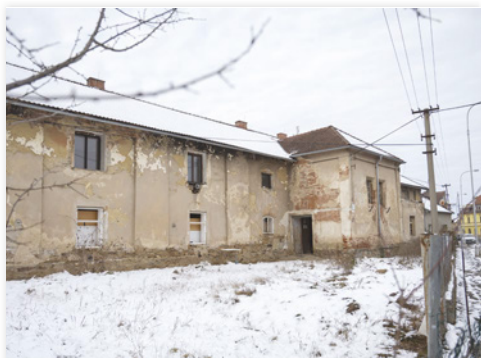
Letos proběhne demolice budovy v ulici Filipovská. Město zde uvažuje o vybudování domu s několika malometrážními byty.
