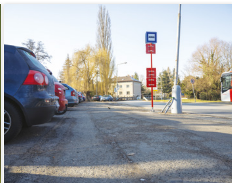
Rekonstrukce parkoviště u SZeŠ počítá s posunem autobusové zastávky.
