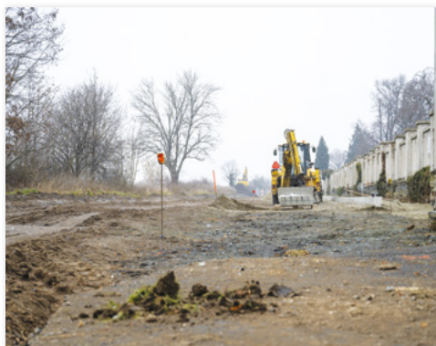
Začátkem února byla zahájena rekonstrukce vozovky u hřbitova.
