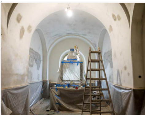
Stavební opravy v Žižkově síni.
