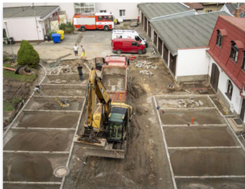
Práce na novém povrchu komunikace ve dvoře radnice v plném proudu.
